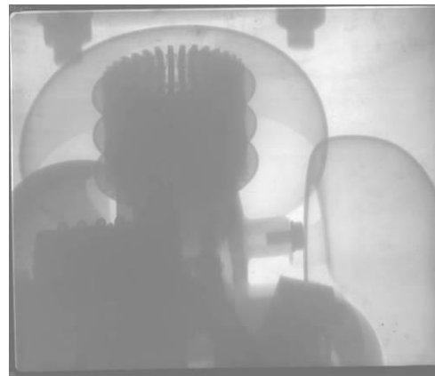
图6 隔离开关分闸状态
