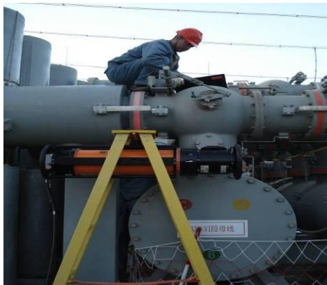
图5 射线机、成像板摆放位置
