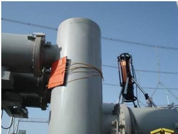
图 9 射线机、成像板摆放位置
