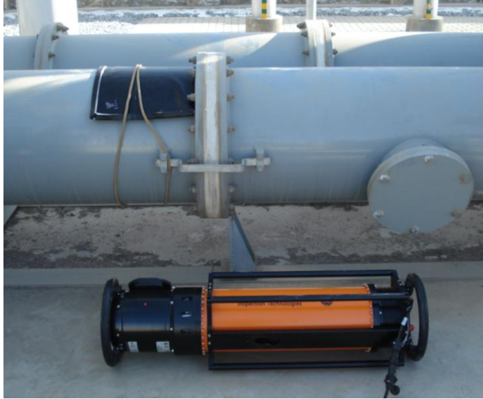
图 7 射线机、成像板摆放位置
